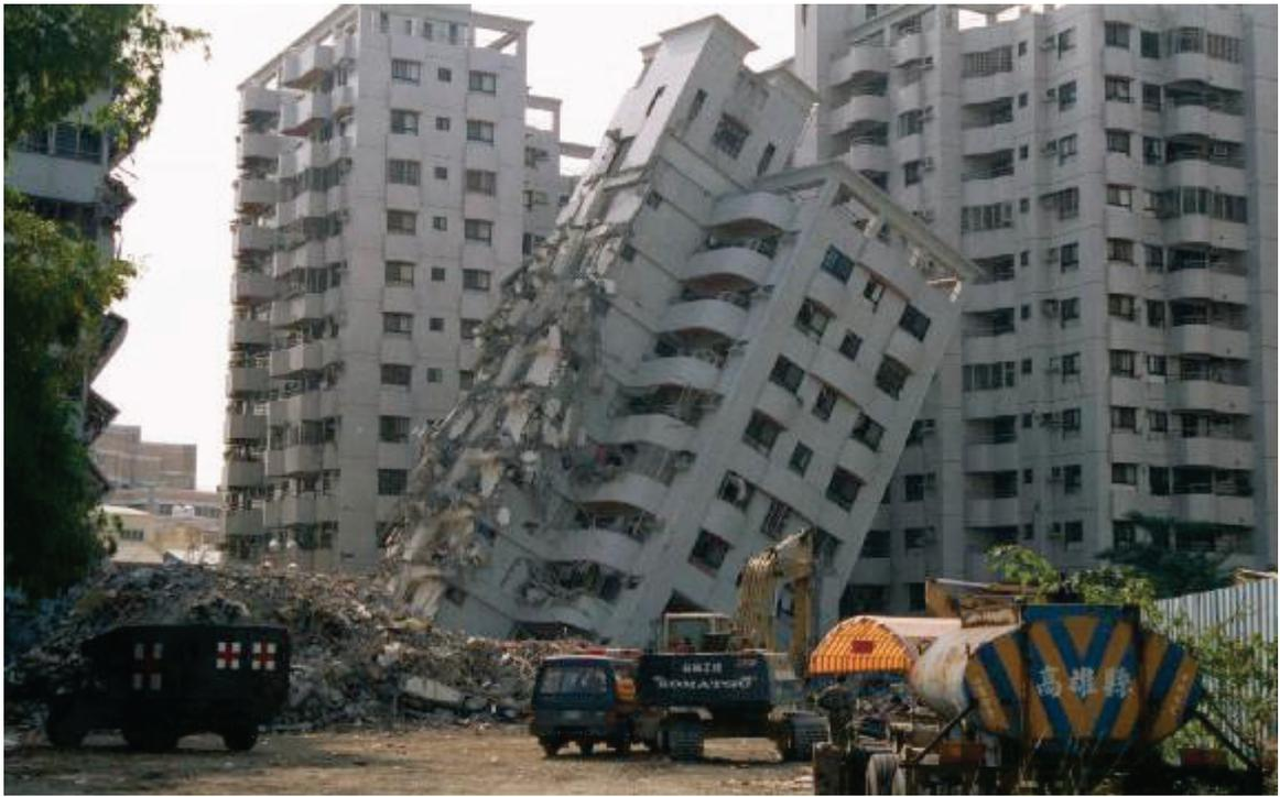
**Рис. 8.1.2. Разрушение высотных зданий землетрясением**
