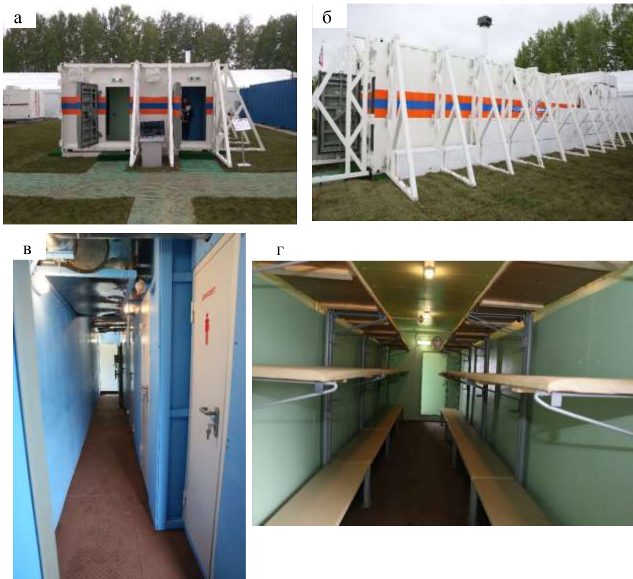
Рисунок 6 – Общий вид убежища из двух блок-модулей полной заводской готовности: а) вид со стороны входа; б) контрфорсы и бетонные блоки; в) коридор технического блока; г) трехъярусные нары блока для размещения 56 укрываемых
