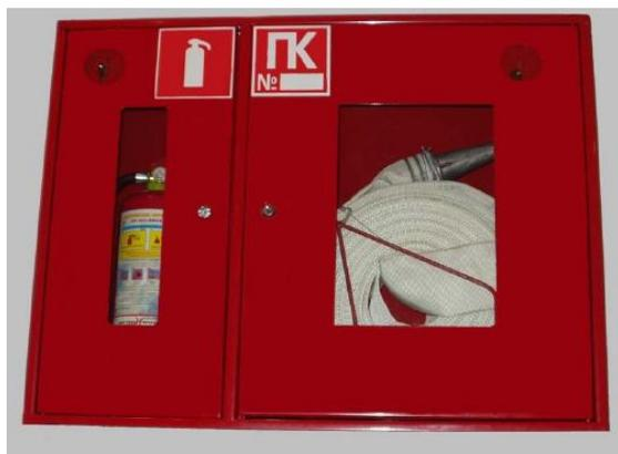
Пожарные шкафы могут быть навесными или встроенными в стен. При установке шкафов на топливоподачах их конструкция не должна допускать скопления пыли. В пожарных шкафах допускается устанавливать ручные огнетушители.
